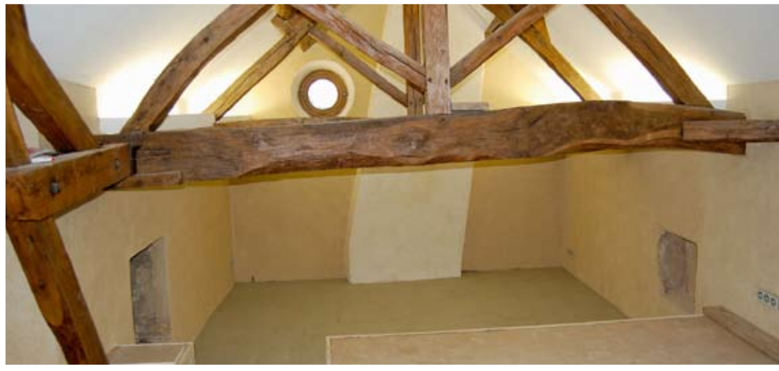
Decorative coating - Entreprise Intérieur Chanvre (71).
