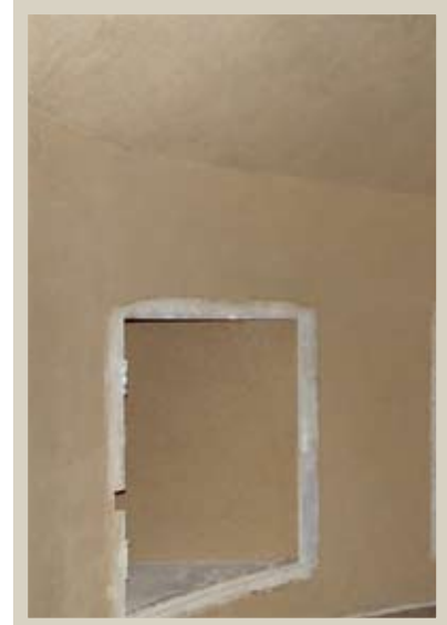
Decorative coating - Entreprise Intérieur Chanvre (71).
